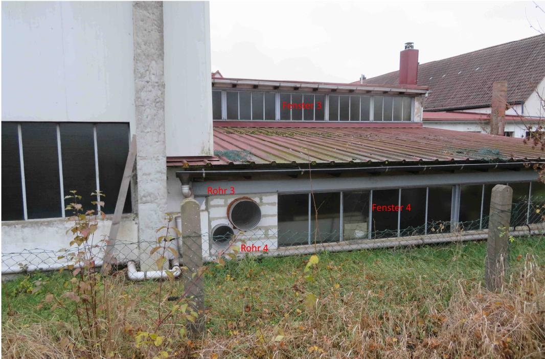
Bild 3 von 10: Halle mittel“ Nordseite mit Benennung der Lärmquellen
